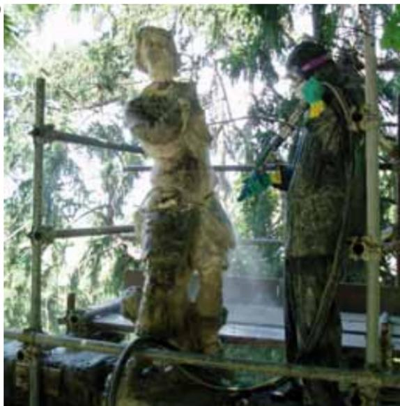
Le esfoliazioni e le scagliature pericolanti sono state fissate iniettando una resina acrilica in soluzione acquosa di densità proporzionale allo spessore delle fessurazioni da colmare (foto 9).
